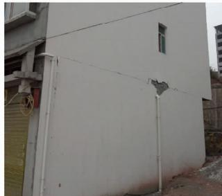
(c) 框架结构房屋呈现的裂缝、脱落
