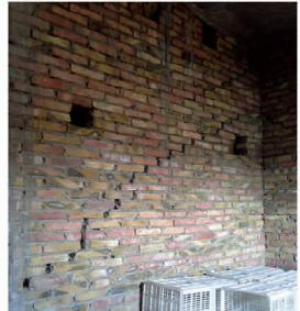
(b) 砖混房屋出现的斜裂缝位错
