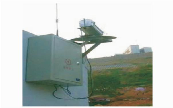
图9 遥测台网安装
